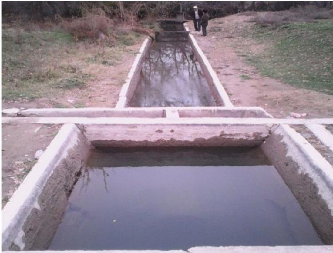
2-сурет –Шу өзініндегі САНИИРИ-Бутыриннің конустық саптамасы типіндегі су өлшеу құрылғысы.
